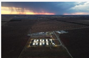
Koorangie Energy Storage System, infrastructure de stockage d'énergie par batteries (BESS) située en Australie
